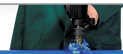
Perforar el tubo
