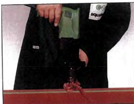
Wykonanie otworu w ścianie rury
