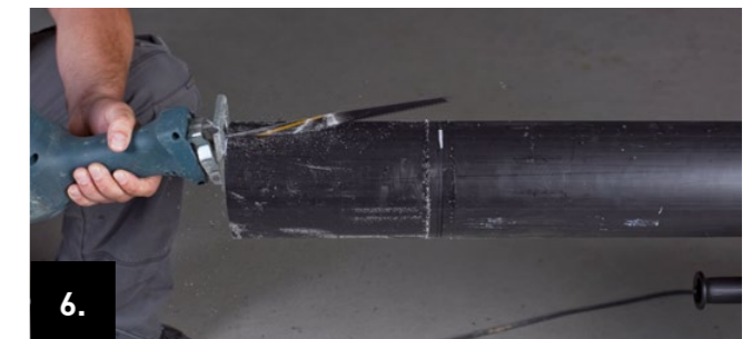
6. Mantel mit handelsüblicher Tigersäge oder Fuchsschwanz mit Sägeblatt für Kunststoff bis auf PUR-Isolierschicht aufschneiden.
