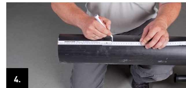
4. Abisolierlänge von 22,5 cm vom Rohrende auf dem Mantelrohr anzeichnen.
