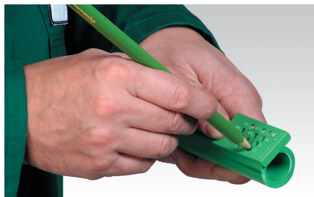
Marcar la profundidad de soldadura con galga
