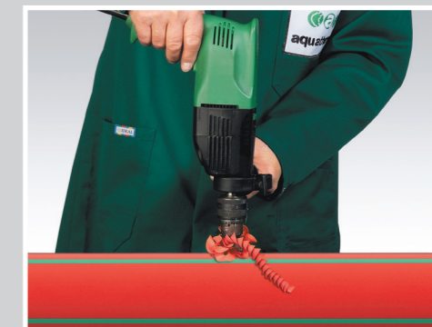
1. Perforar el tubo (con taladro convencional) (30 seg.)
