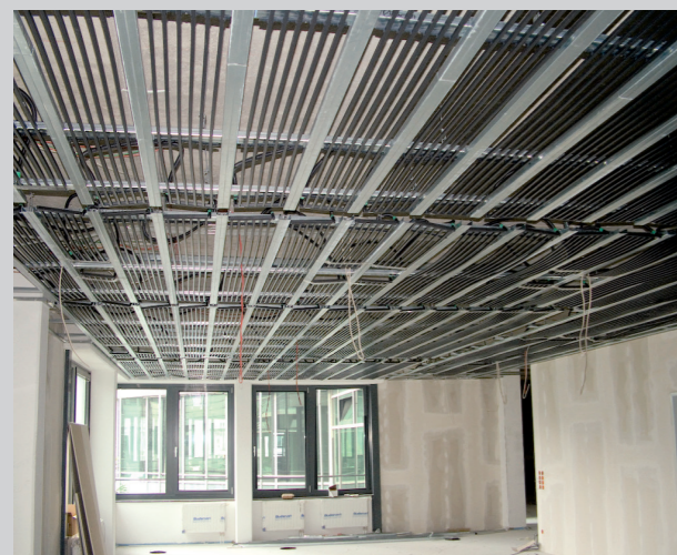
Instalación en falso techo
