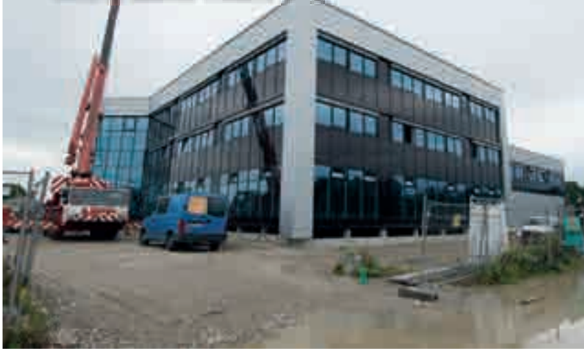
Clinica Sanitaria Heinze, RosenHeim Techo de cassette metálico
