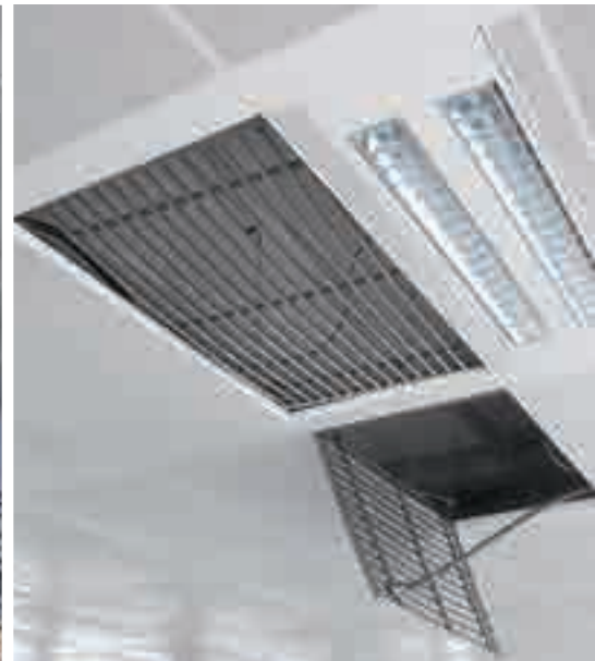
Sky Office, Zagreb, Kroatien Techo de placas de yeso laminado con subestructura metálica
