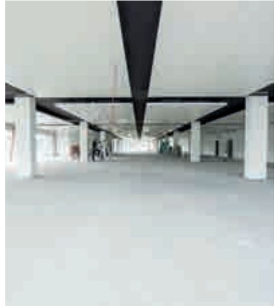
Sky Office, Zagreb, Kroatien Techo de cassette metálico como sistema de sujeción
