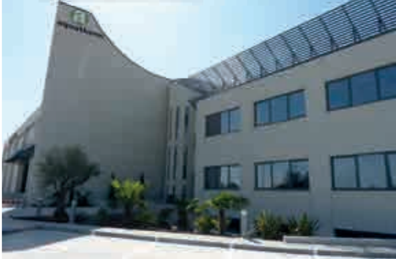
AQUATHERM IBÉRICA, Oficinas Madrid Techo de cassette metálico
