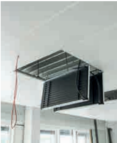
DekoGraphics en St. Leon-Rot, Alemania Sistema para extracción de calor ambiente y radiación, para bomba de calor y enfriamiento fotovoltaico
