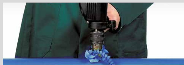
Perforar el tubo
