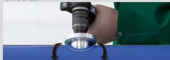
Retirar la barrera de oxígeno en la tubería aquatherm blue pipe OT
