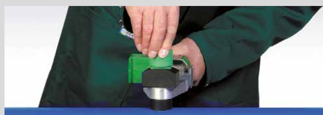
...calentando la tubería y el accesorio
