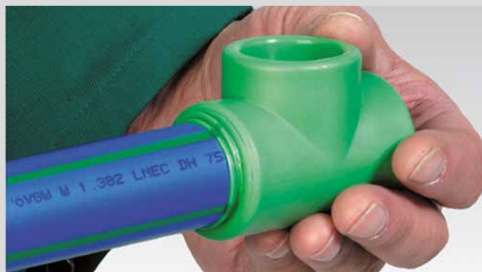
...alineación del tubo y accesorio.
