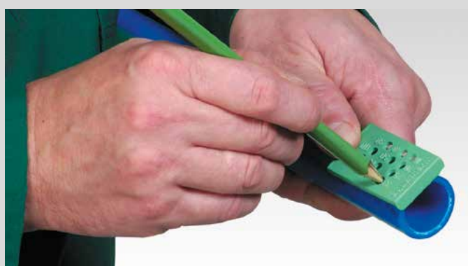
marcar la profundidad de soldadura con la galga
