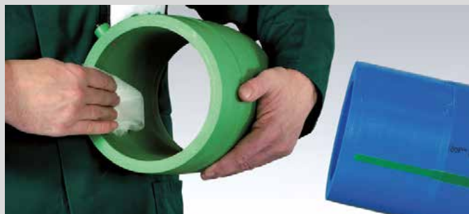
Limpiar la superficie interior del manguito electrosoldable, empleando un paño o papel que no deje residuos. Eliminar la humedad que puede aparecer, inmediatamente antes de empezar el proceso de soldadura
