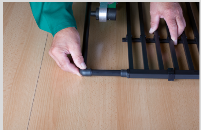
Soldadura de las tuberías de conexión entre paneles.
