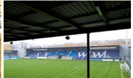
Brita Arena Wiesbaden, Alemania
